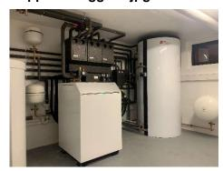
Die alten Öltanks sind einer modernen Luft/Wasser Wärmepumpe gewichen.
