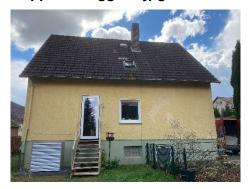
Vor Beginn der Fassadenarbeiten ist zur Gartenseite bereits eine neue Ausgangstür entstanden. Ebenfalls installiert ist der zur Luft/Wasser Wärmepumpe gehörende Ventilator (links) zum Ansaugen der Außenluft.
