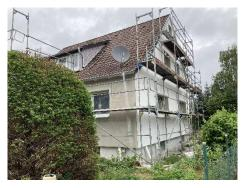
Für den Hausbesitzer und Energieberater Tomas Titz war eine Fassadendämmung auf Basis von Steinwolle Dämmplatten alternativlos.
