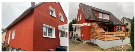
Erfolgreiche Sanierung: Gezielte Maßnahmen ermöglichten eine jährliche Senkung des Energieverbrauchs von 283 kWh/m² auf 44 KWh/m². Der Transmissionsverlust sank von 1,184 W/m²k auf 0,487 W/m²k. Letztlich verringerte sich der Endenergiebedarf des Gebäudes von 250 kWh/m²a auf nur noch 57 kWh/m²a.
